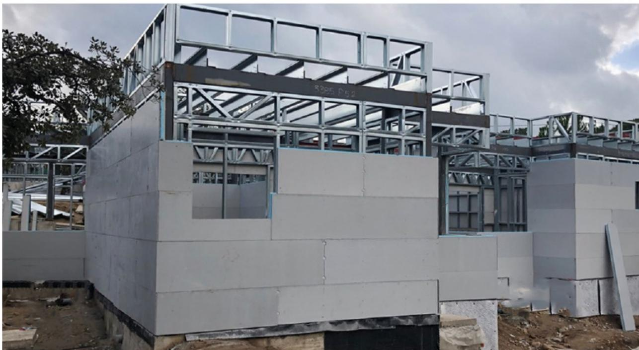
Seleccionamos un punto para el inicio del replanteo que estará situado en una de las esquinas inferiores de la estructura sumándole el ancho del panel a usar en la fachada. Los apoyos estarán separados 60cm entre ejes, como máximo. Trataremos de aprovechar al máximo cada panel, teniendo en cuenta que cada pieza tendrá como mínimo tres apoyos.
