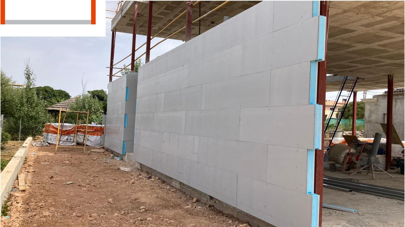
Compuesto de panel exterior TFbcY de núcleo aislante variable y trasdosado interior COAT de doble placa. Disposición de montantes cada 60cm. La cara de fibrocemento hacia el exterior. Acabado exterior libre.
