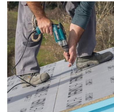
2 Fijación del panel con tres tornillos PLUS por cada apoyo
