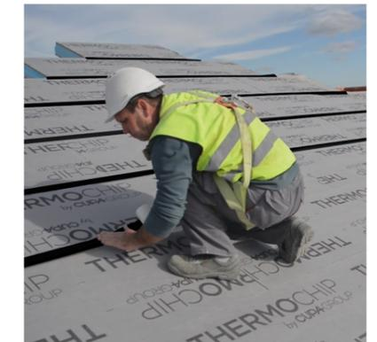
3 Sellado de las juntas, sin arrugas ni burbujas, con cinta adhesiva
