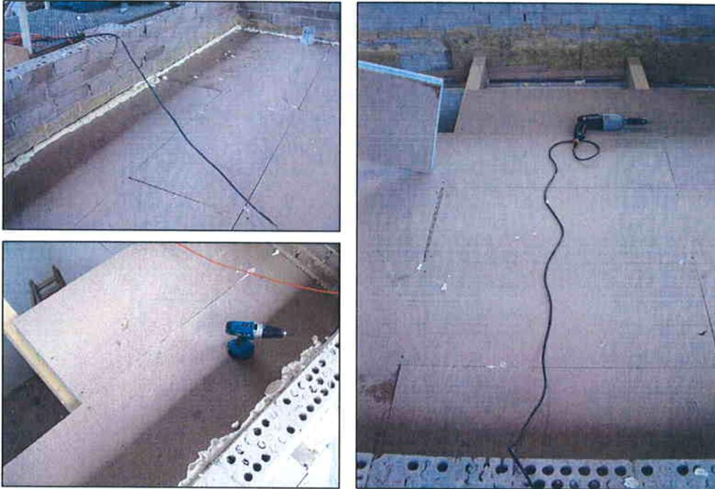
**Fotografías 7, 8 y 9 Colocación paneles Thermochip**
