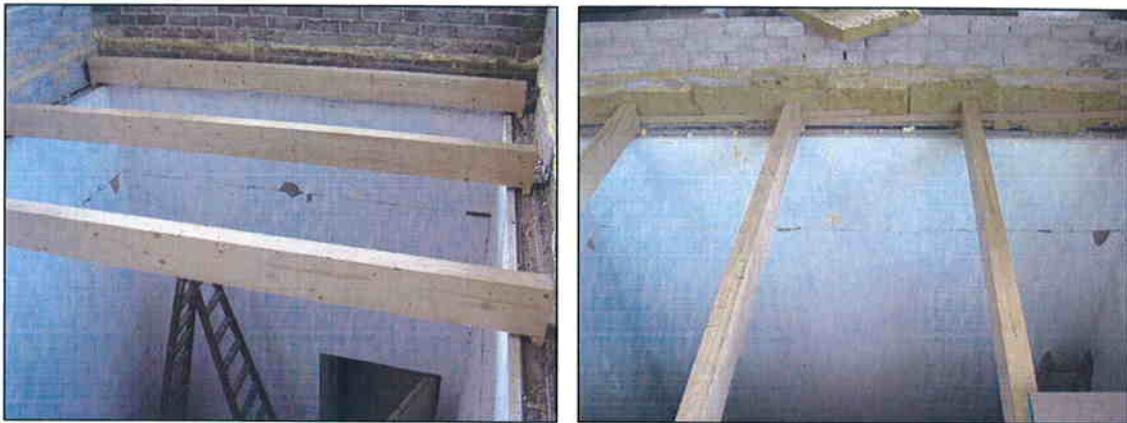
**Fotografías 2 y 3 Colocación de las vigas en la sala de transmisión del laboratorio**
